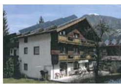
Haus Kupfner Kaltenbach
