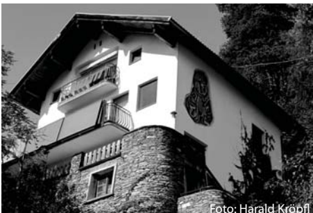
Foto: Harald Kröpf vor der Sanierung
