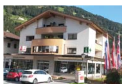
Geschäftshaus Zell am Ziller Zell am Ziller Energieausweis nach Sanierung: Kategorie B, 65 % Verbesserung
