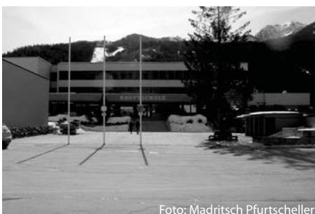
Foto: Madritsch Pfurtscheller vor der Sanierung
