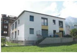
PH-Wohnanlage Pradlerstraße Innsbruck Energieausweis nach Sanierung: Kategorie A++, 97 % Verbesserung
