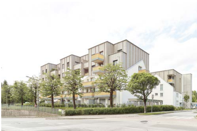
Abbildung 12: Wohnanlage Friedrich-Inhauser-Straße in Salzburg, Außenansicht vorne; Bild: Atelier Wortmeyer
