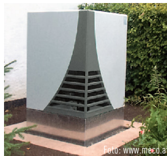
Abb.13: Außenverdampfer - entzieht der Außenluft Wärme und stellt diese der Wärmepumpe zur Verfügung
