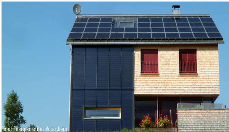
Abb. 18: Symbolfoto einer Photovoltaikanlage
