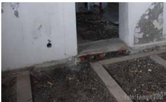
Abb.: Sandschüttung in bestehendem Deckenaufbau
