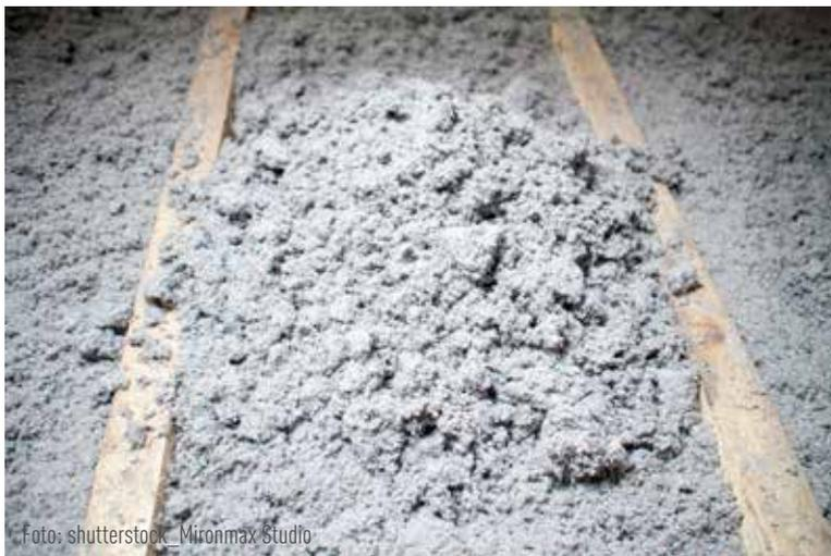
Abb.: Dämmstoff Zellulose zwischen einer Holzkonstruktion
