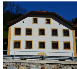
WOHNHAUS M 6571 Strengen
