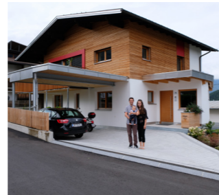
SANIERUNG MIT AUGEN- MASS - WOHNHAUS OSTERSTEIN 6471 Arzl im Pitztal
