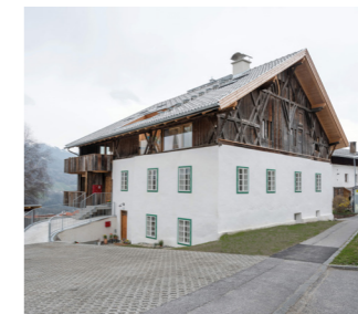
REVITALISIERUNG KASPERHOF 6082 Patsch
