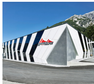
SANIERUNG BETRIEBSGEBÄUDE 6166 Fulpmes
