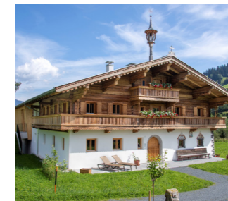
SANIERUNG HOF UNTERSTEGEN 6370 Kitzbühel
