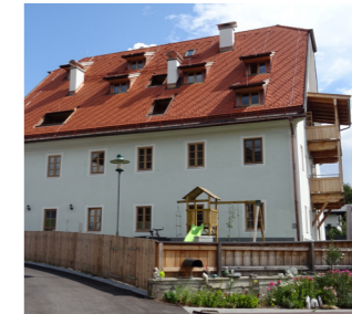
SANIERUNG FLÖSSERHAUS 6200 Jenbach
