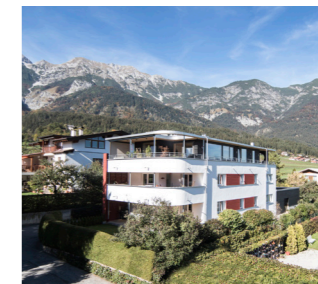
SANIERUNG, ZUBAU UND AUFSTOCKUNG ZWEIFAMILIENHAUS 6063 Rum
