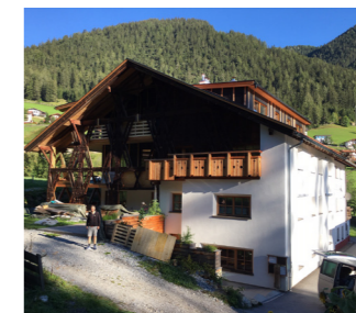
SANIERUNG BAUERNHOF IN MULTIGENERATIONEN- HAUS 6152 Trins
