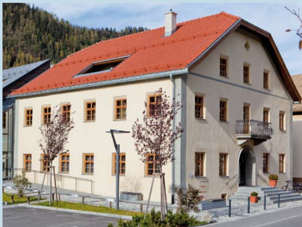
Das Bürgerhaus aus dem 19. Jahrhundert erstrahlt mit Original-Malereien, Kastenfenstern und Tonziegeldach in neuem Glanz – und das auf energietechnisch höchstem Niveau.
