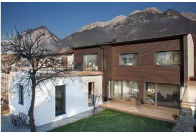
Wohnhaus nach Sanierung, Foto Tiroler Sanierungspreis 2011
