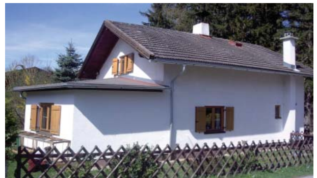
Wohnhaus vor Sanierung, Foto: Tiroler Sanierungspreis 2011
