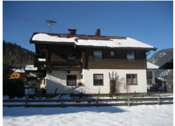
Wohnhaus vor Sanierung, Foto Tiroler Sanierungspreis 2011
