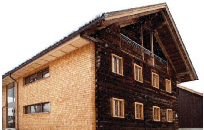
Wohnhaus nach Sanierung, Foto Tiroler Sanierungspreis 2009
